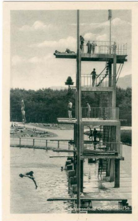
Sprungturm in Betonrahmenkonstruktion, Waldstrandbad Großschänau, Postkarte um 1950
